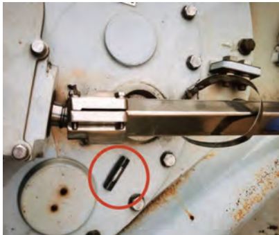
图1 分接开关传动轴销脱落位置
