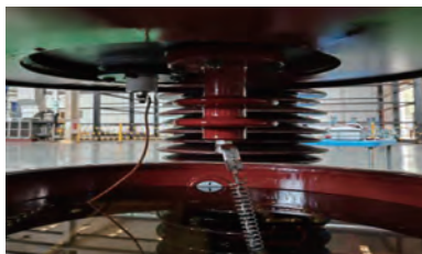
a) 中压套管及引线
