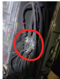
a) 案例1:电缆接头老化
