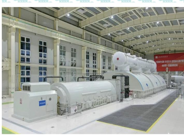
机组工作转速设置合适的磁极对数即可。汽轮发电机组的工作转速为3000r/min,由上述公式可知其对应50Hz的频率,设置一对磁极对数即可。另根据上述所说的,大家也可算算核电站机组的工作转速为:1500r/min,水电站水轮机组的工作转速为750r/min,要发出的50Hz频率交流电来,应装多少磁极对数?发电机当其磁极数固定不变时,其频率f和转速n成正比关系,这是同步发电机的最大特点,也是同步发电机的调频原理。
