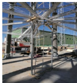
图 18 辐射筋支架临时支撑示意
