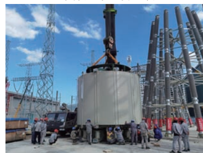
图13 电抗器本体与支撑平台组装示意
