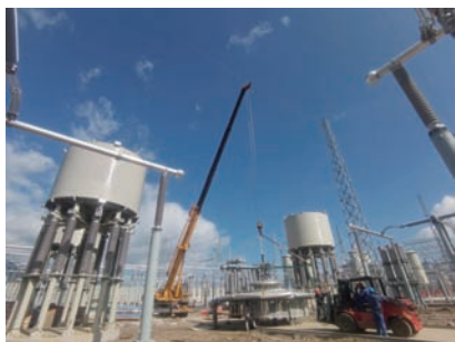
图 17 电抗器消声器安装示意
