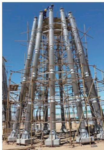
图11 脚手架及防护网安装后示意
