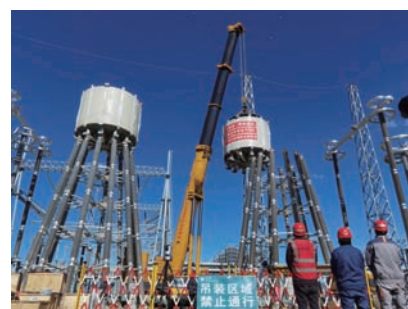
图15 电抗器本体吊装示意
