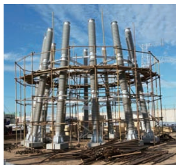
图10 脚手架逐层搭设示意
