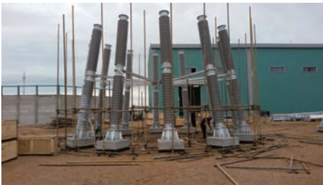
图8 支柱绝缘子安装示意
