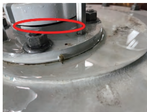
图1 压力释放阀漏油
