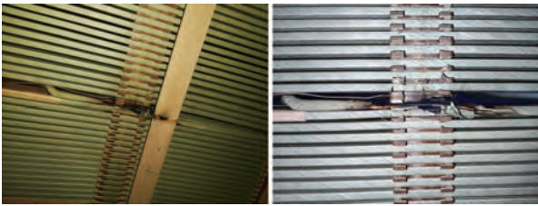
图 4 解体检查情况
