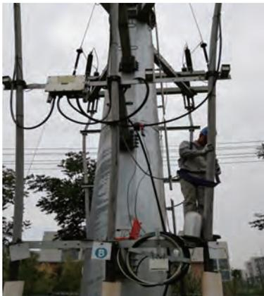
(b)实际传感器安装示意图
