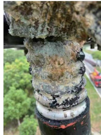
图7 封铅不良缺陷照片
